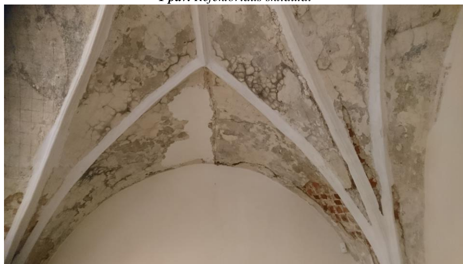
2 pav. Refektoriaus skliauto tinko pažeidimai ir polichromijos natektys
