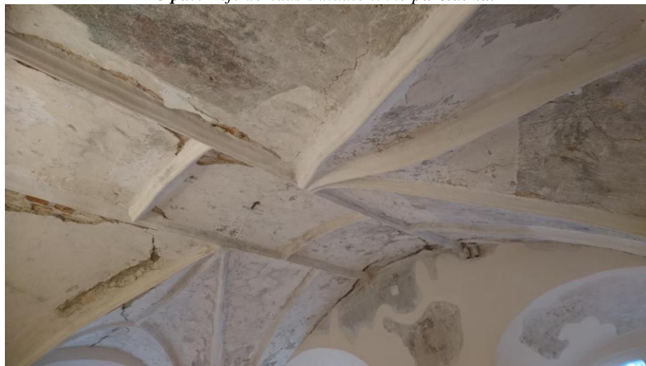
4 pav. Refektoriaus skliauto tinko pažeidimai
