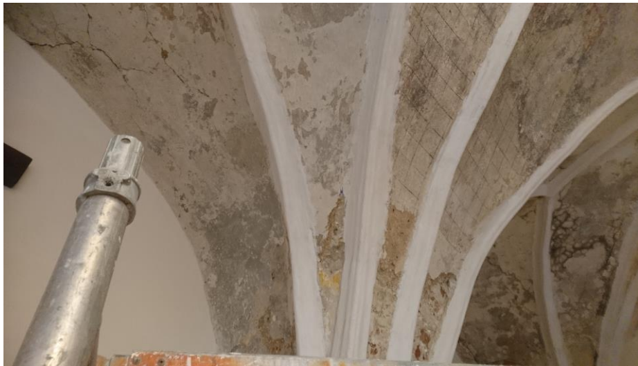
3 pav. Refektoriaus skliauto tinko pažeidimai
