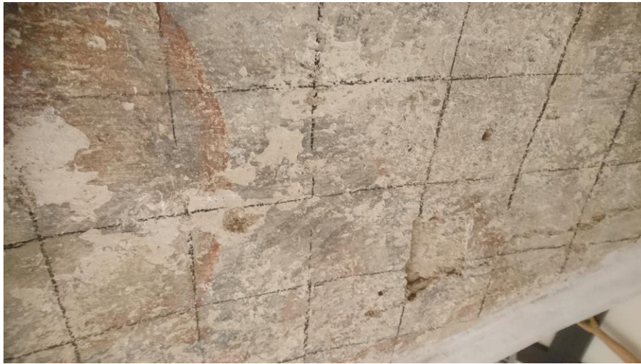
9 pav. Refektoriaus skliauto polichrominio dekoru pažeidimai ir sudalijimas į kvadratus
