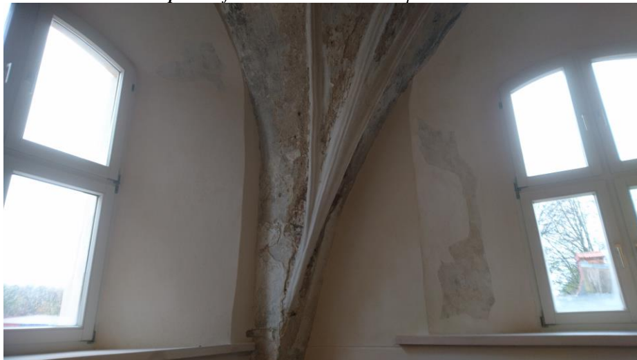
5 pav. Refektoriaus skliauto tinko pažeidimai
