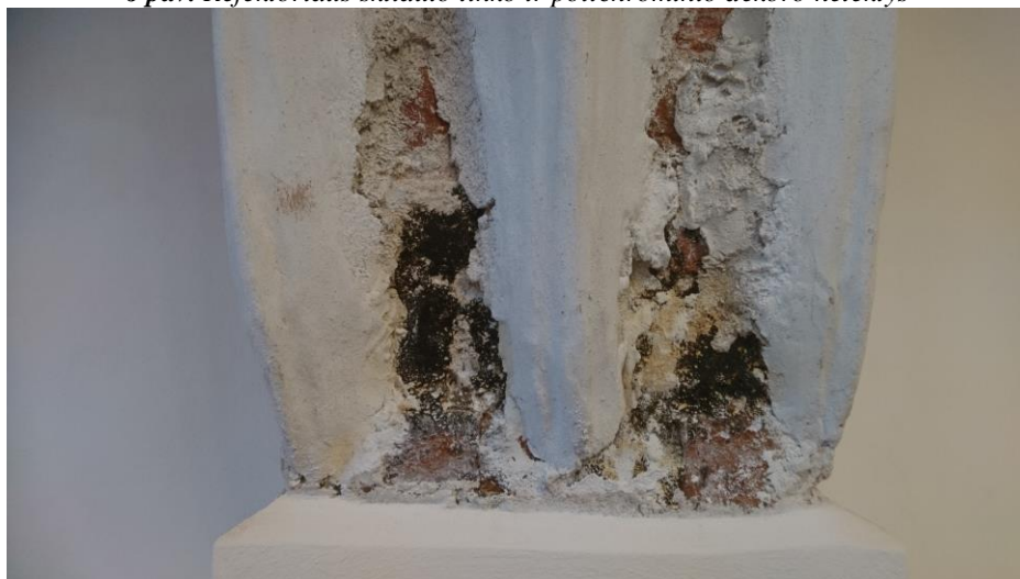
7 pav. Refektoriaus skliauto pėdos tinko netektys ir cementinių skiedinių fragmentai
