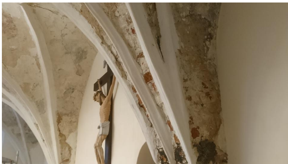
6 pav. Refektoriaus skliauto tinko ir polichrominio dekoru netektys
